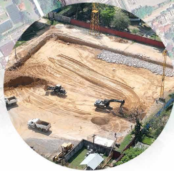
Ampliación de área y pavimentación "Predio los Monos"
